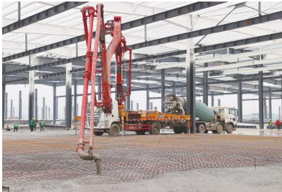
通威太阳能彭山基地建设现场
