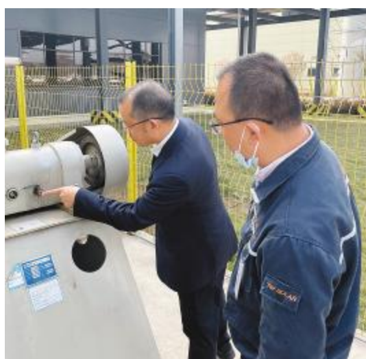
安全检查现场
